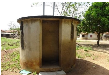
Image 5 : Sanitaire à Notsè, novembre 2019, avant PASPEV. (Source : ONG Creuset-Togo, Coordonnateur du PASPEV)
