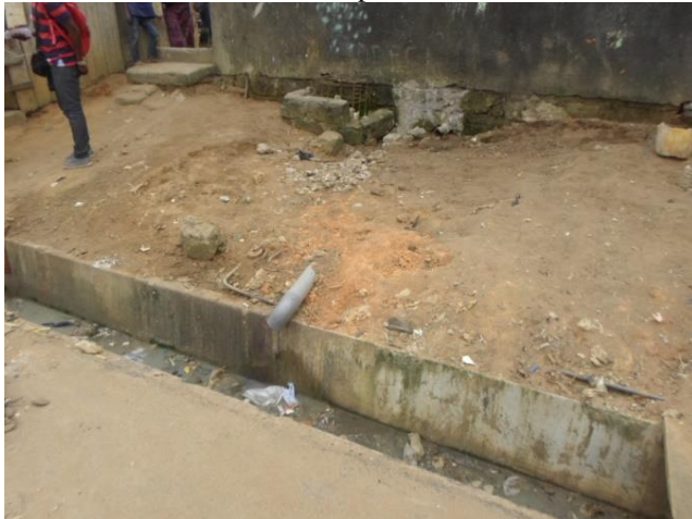
Photo 2 : Un caniveau obstrué par les déchets solides à Abobo Centre (Prise de vue : Diabagaté, Août 2021).
