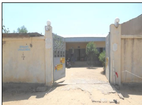
Photo n° 5 : Bâtiment du centre de santé de Koundoul construit en 2011
