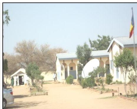
Photo n°6 : Hôpital de district de Mandélie construit en 2011
