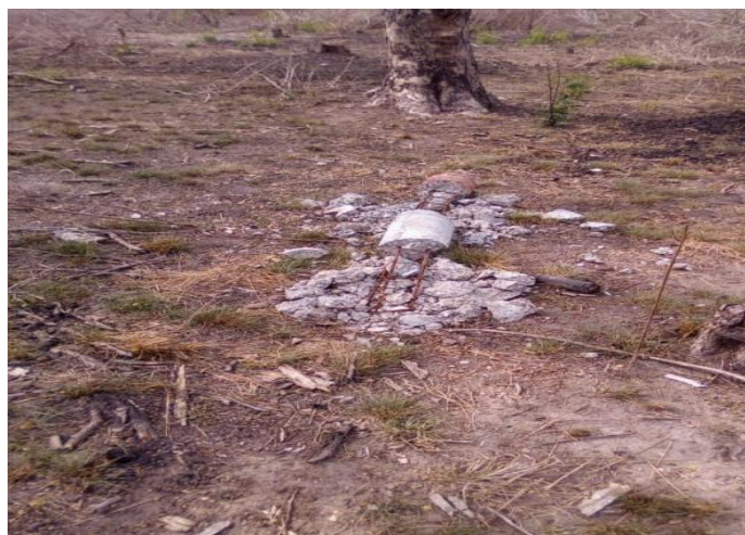
Photo n°1 : Balise de la piste arrachée et cassée
