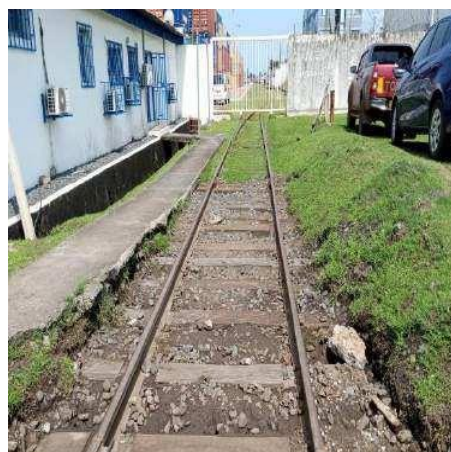
Photo 2 : Voie ferrée en rails vignoles
