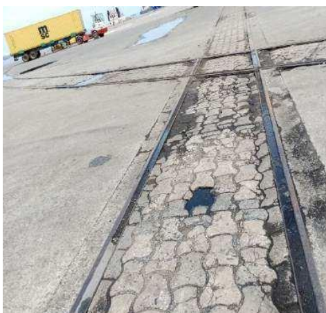
Photo 1 : Voie ferrée en rails à gorge
