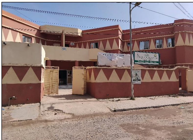
Photo 3: Poste de santé entièrement réhabilité par le projet TI-ODD GTFC Crédit de photo, E.H.R BA, 2024
